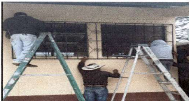
Foto 7: Realización de balcones de hierro en ventana, en modulo 3.
