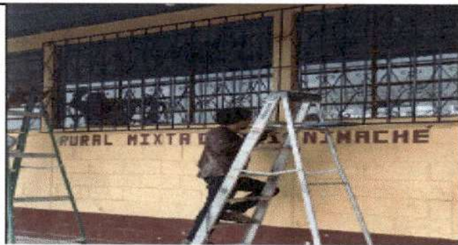
Foto 9: Realización de balcones de hierro en ventana, en modulo 3.
