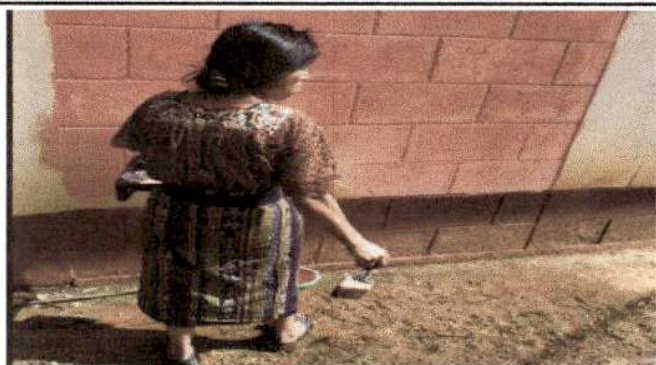
Foto 15: Realización de Pintura en exteriores e interiores, en modulo 5.
