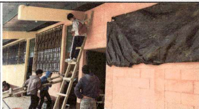
Foto 13: Realización de Pintura en exteriores e interiores, en modulo 5.
