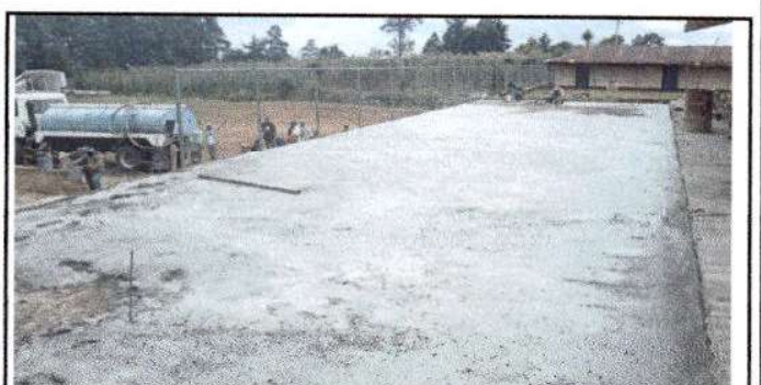
Foto 6: Realización de reparacion de planchas de concreto de patio, en modulo 2.
