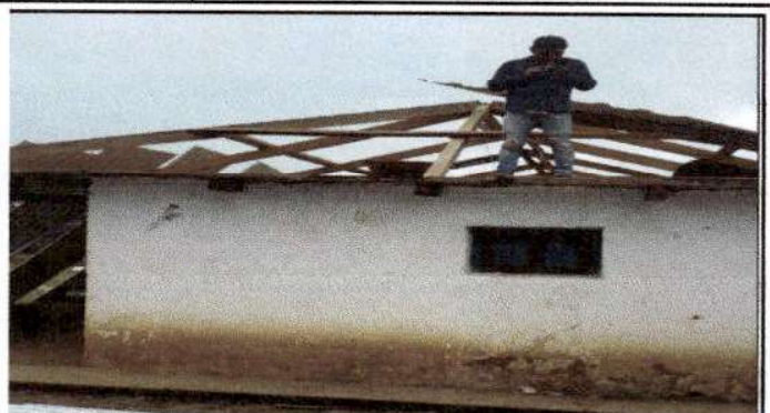
Foto 2: Realización de sustitucion de capotes, en modulo 1.
