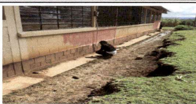
Foto 14: Realización de Pintura en exteriores e interiores, en modulo 5.
