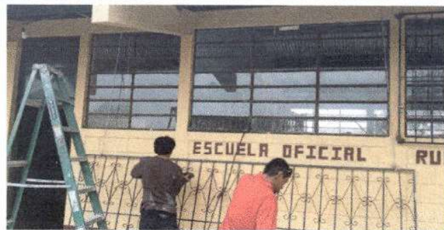
Foto 8: Realización de balcones de hierro en ventanas, en modulo 3.
