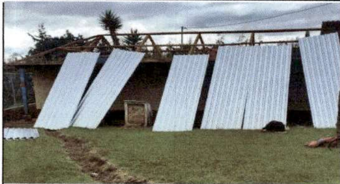
Foto1: Realización de sustitucion de lamina por lamina troquelada aluzinc calibre 26, en modulo 1.
