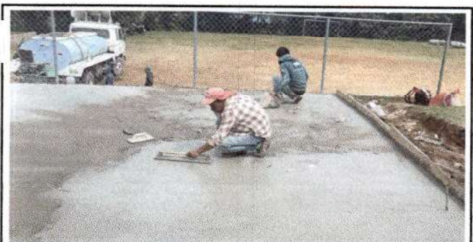
Foto 5: Realización de reparacion de planchas de concreto de patio, en modulo 2.
