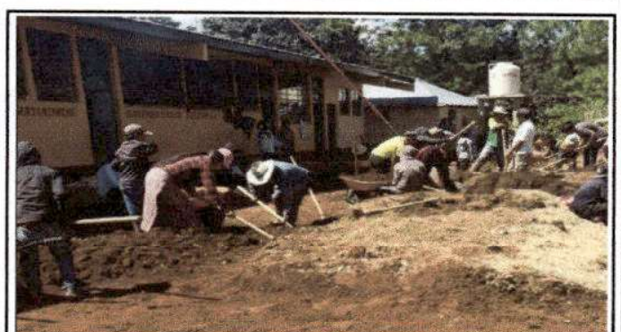
Foto 4: Realización de reparacion de planchas de concreto de patio, en modulo 1.
