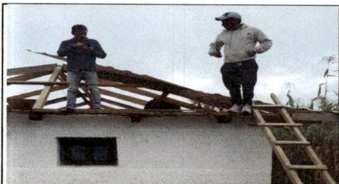
Foto 3: Realización de sustitucion de lamina troquelada aluzinc calibre 26, en modulo 1.
